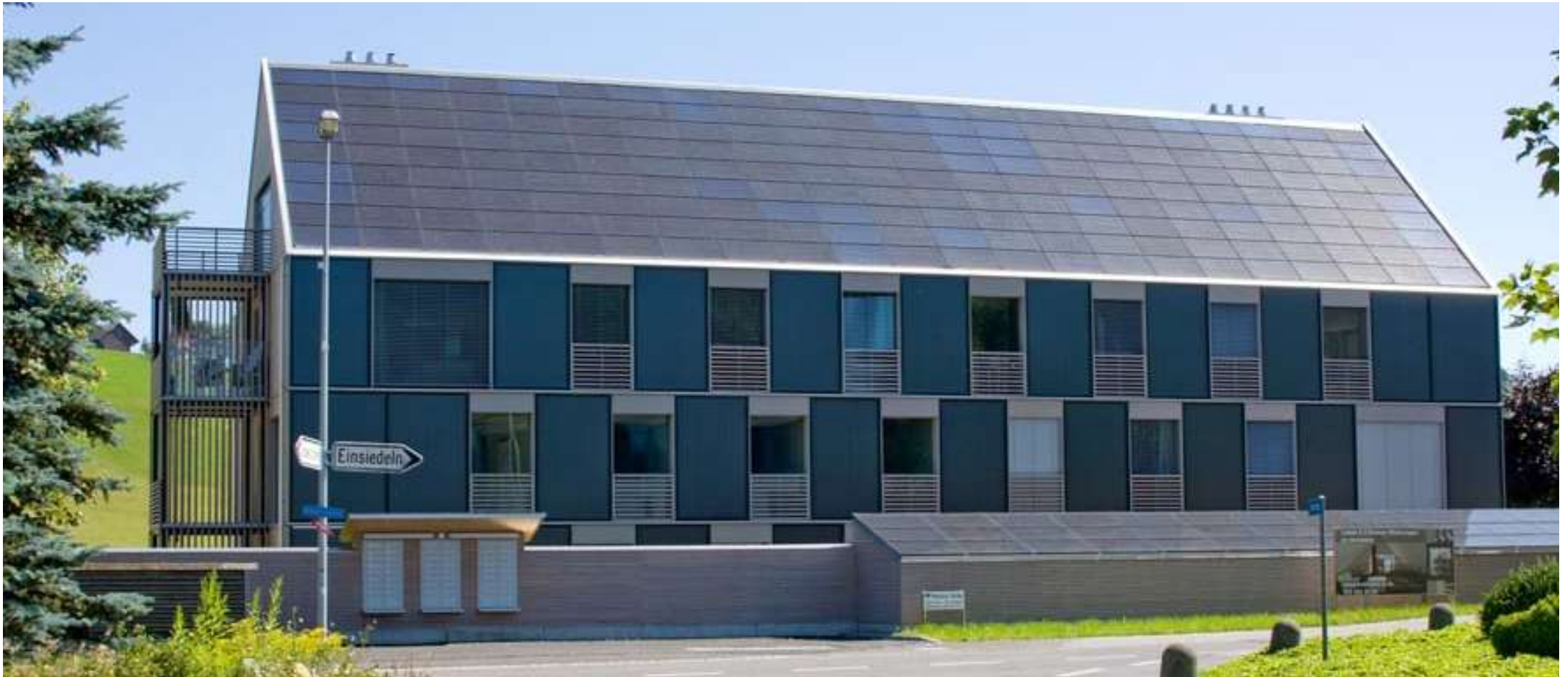
Kraftwerk B, Bennau
