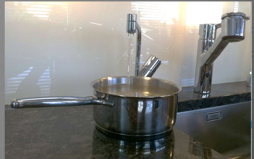
Heisswasser in der Küche
